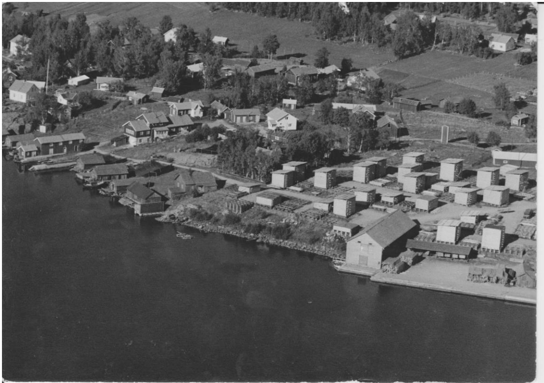
Satamalahtea jossa oikealla on Kouhin sahan tapuleita ja rantamakasiini. ( päin merta pitkä rakennus). Nykyisin ravintola ja Krookan katsomo ja näyttämö. Postikortti .
